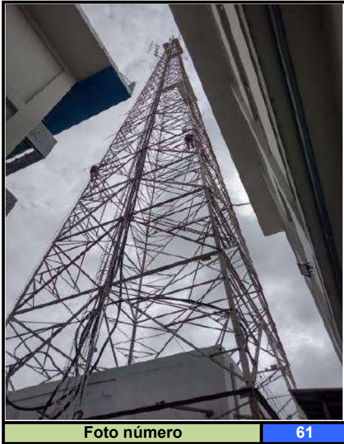
Leg. (Foto 61) PANORÂMICA DA TORRE TORRE= 90M + TUBULÃO DE 15M TOTALIZANDO = 105M Leg. (Foto 62)
