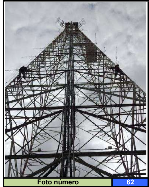
Leg. (Foto 61) PANORÂMICA DA TORRE TORRE= 90M + TUBULÃO DE 15M TOTALIZANDO = 105M Leg. (Foto 62)
