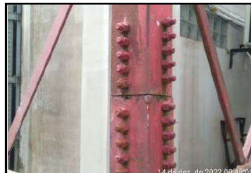
Leg. (Foto 25) CABEAMENTO E CONEXÕES EXISTENTES Leg. (Foto 26) PARAFUSOS E PORCAS OXIDADOS
