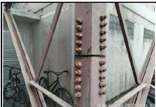
Leg. (Foto 25) CABEAMENTO E CONEXÕES EXISTENTES Leg. (Foto 26) PARAFUSOS E PORCAS OXIDADOS
